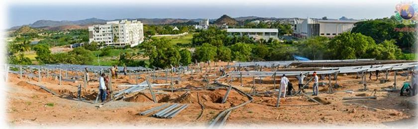
Der Trust nahm also die Herausforderung an, jenen Hügel in drei Stufen anzulegen, mit stabilen Stützelementen, damit auf jeder Ebene ein Satz Platten in der exakten erforderlichen Neigung montiert werden konnte. Es waren 21 Tage hektischer Erdarbeiten und weitere 21 Tage sorgfältiger Montage der Platten.
