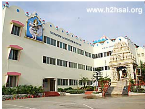
Das eindrucksvolle Gebäude, das sich eher wie ein Ort des Gottesdienstes anfühlt und nicht wie eine konventionelle Schule.
