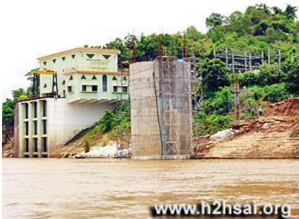
In Ansaugstationen wie dieser hier wurde Flusswasser gesammelt (Die Aufnahmen entstanden während der Bauarbeiten)
