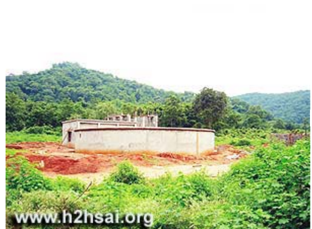
Viele Wasserspeicher und Aufbereitungsanlagen wie diese wurden zur Versorgung mit sauberem Trinkwasser gebaut.
