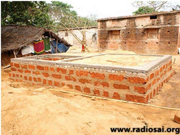
Der erhöhte Sockel als Schutzvorrichtung gegen zukünftige derartige Verwüstungen – dieser ist aus Laterit-Stein errichtet.
