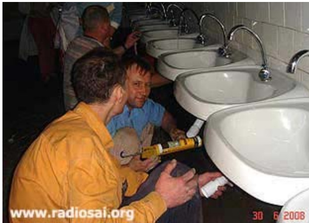
Die Baubrigade bei der Arbeit ein Badezimmer zu restaurieren.
