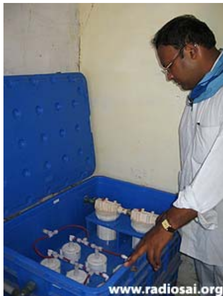
Ein Sevadai inspiziert den Zustand der Wasserreinigungseinheit.
