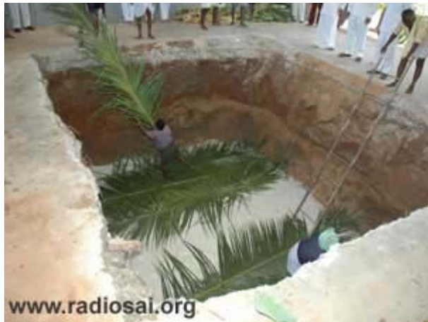
Die speziell vorbereitete Grube...
