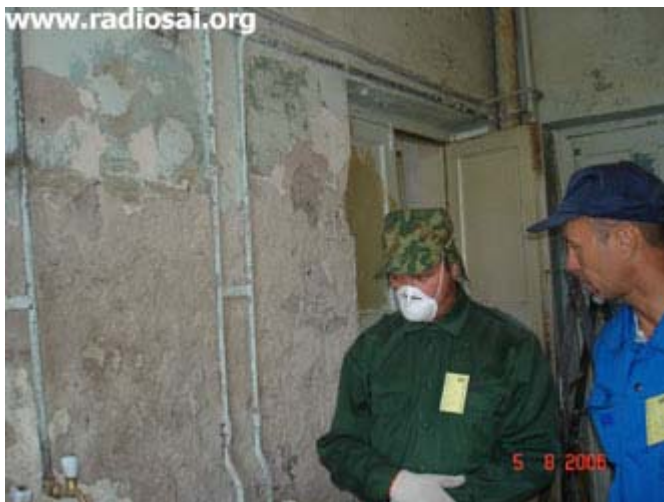
Das Reparatur-Team vor Ort ...
