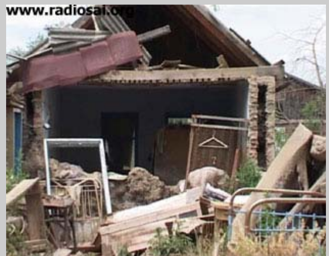
und beseitigten den Schutt.
