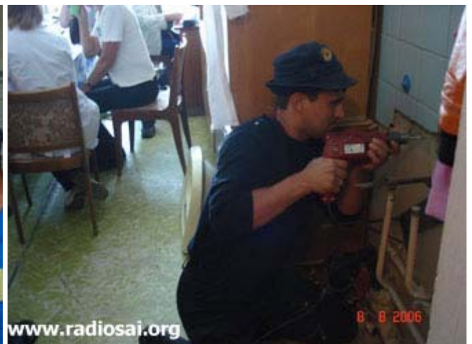
...repariert die sanitären Anlagen.
